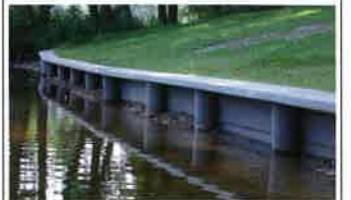
TRIMAX als Uferbefestigung
