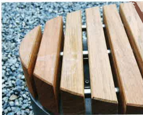
Auf die Details kommt es an. Bild ganz links: Nagelfluhwand mit Blattgoldbeschichtung im Stadtpark von Burghausen. Links: Sitzelement mit verdeckten Befestigungselementen (Entwürfe: Rehwaldt Landschaftsarchitekten).
